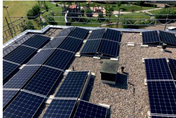
Die beiden Mehrfamilienhäuser mit 42 Wohnungen wurden 1986 erstellt. Nach 33 Jahren mussten die Flachdächer erneuert werden. Diese wurden einerseits mit einer wesentlich besseren Isolation versehen und andererseits wurde der Dachrand so breit ausgelegt, dass zu einem späteren Zeitpunkt eine zusätzliche Fassadenisolation unter dieser Blechverkleidung angebracht werden kann.
