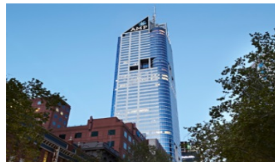
Australisches Büroobjekt Melbourne, Australien 66 000 m 2 Büros, Core
